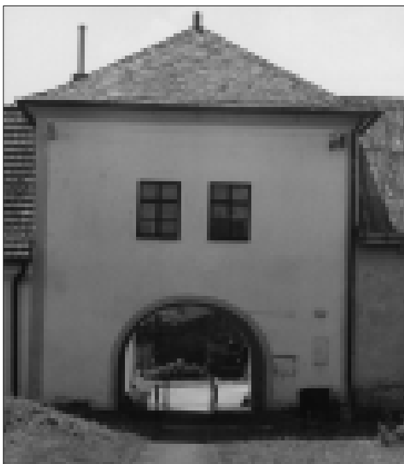
Obr. 6. Osek nad Bečvou. Vjezdová brána u domu na návsi. Foto autor.
