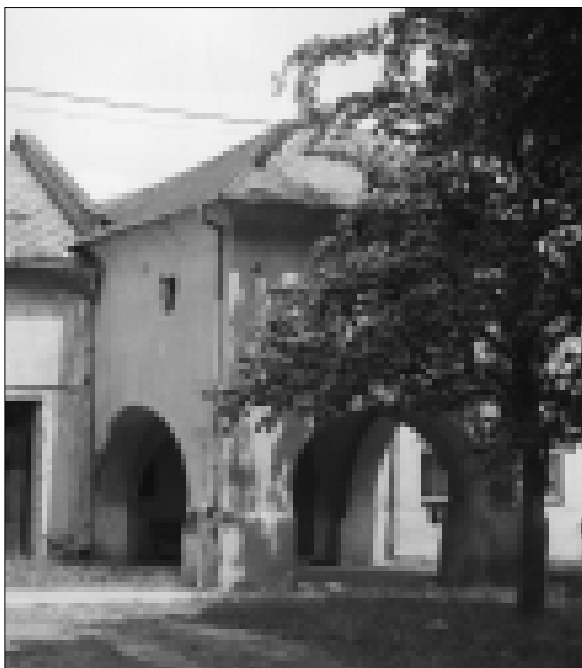
Obr. 5. Lobodice. Hanácký žudr u domu č. 47 na návsi v roce 2003. Oblouky žudru jsou uvedeny do původního stavu. Foto autor.
