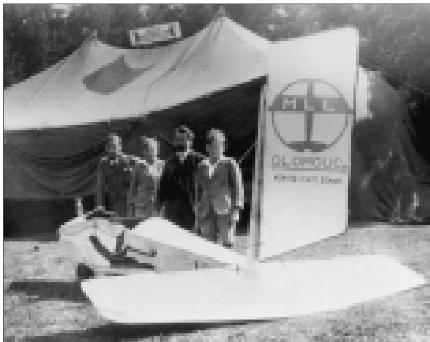
Obr. 1. Škola bezmotorového létání MLL, Chomýž, červenec–srpen 1931. Hangár, kluzák „Čáp“.
