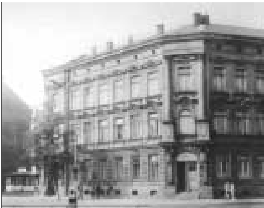
Nájemní dům továrníka Calábka v Husové ulici č. 2 v r. 1960
