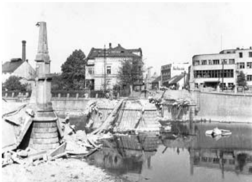
Zbytky Tyršova mostu po 8. 5. 1945. SOKA Přerov
