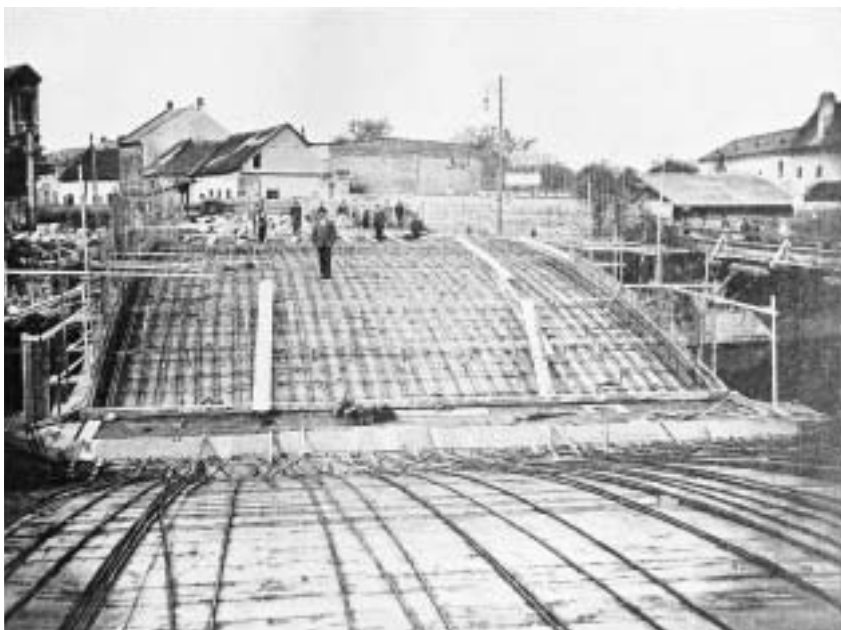
Upravování železné armatury oblouků. SOkA Přerov
