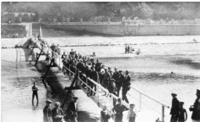
Dřevěná lávka pro pěší v místech pozdější lávky U Loděnice. 20. léta 20. st. Ze sbírky J. Hlouška
