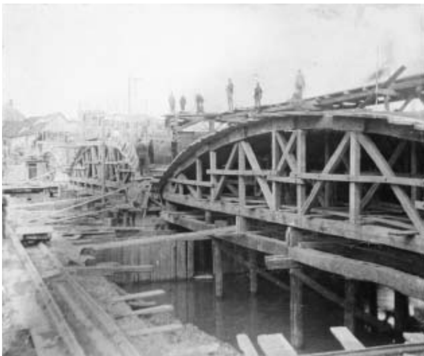
Pohled na skruže mostu přes Bečvu. SOkA Přerov
