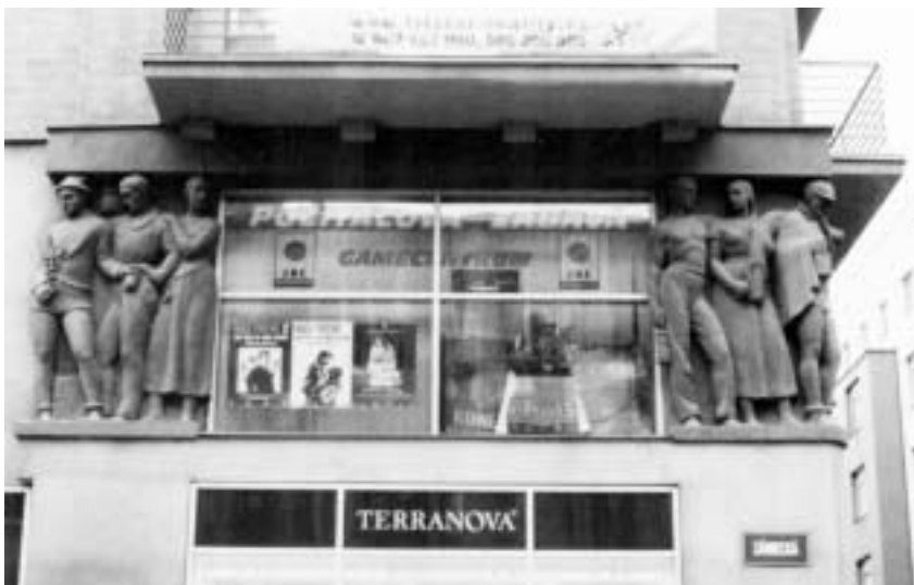
Bývalá pojišťovna Riunione Adriatica di Sicurta, Ostrava, 1927
