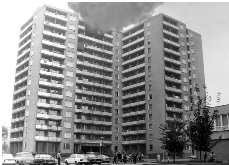
Požár 12. NP výškového domu, ul. Budovatelů
