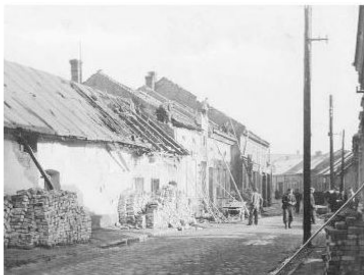
PO BOMBARDOVÁNÍ. Dům paní Dorazilové opravují po bombardování. Na střeše je na snímku vidět dvojice pokrývačů. Foto: archiv Jiřího Rozmuse
