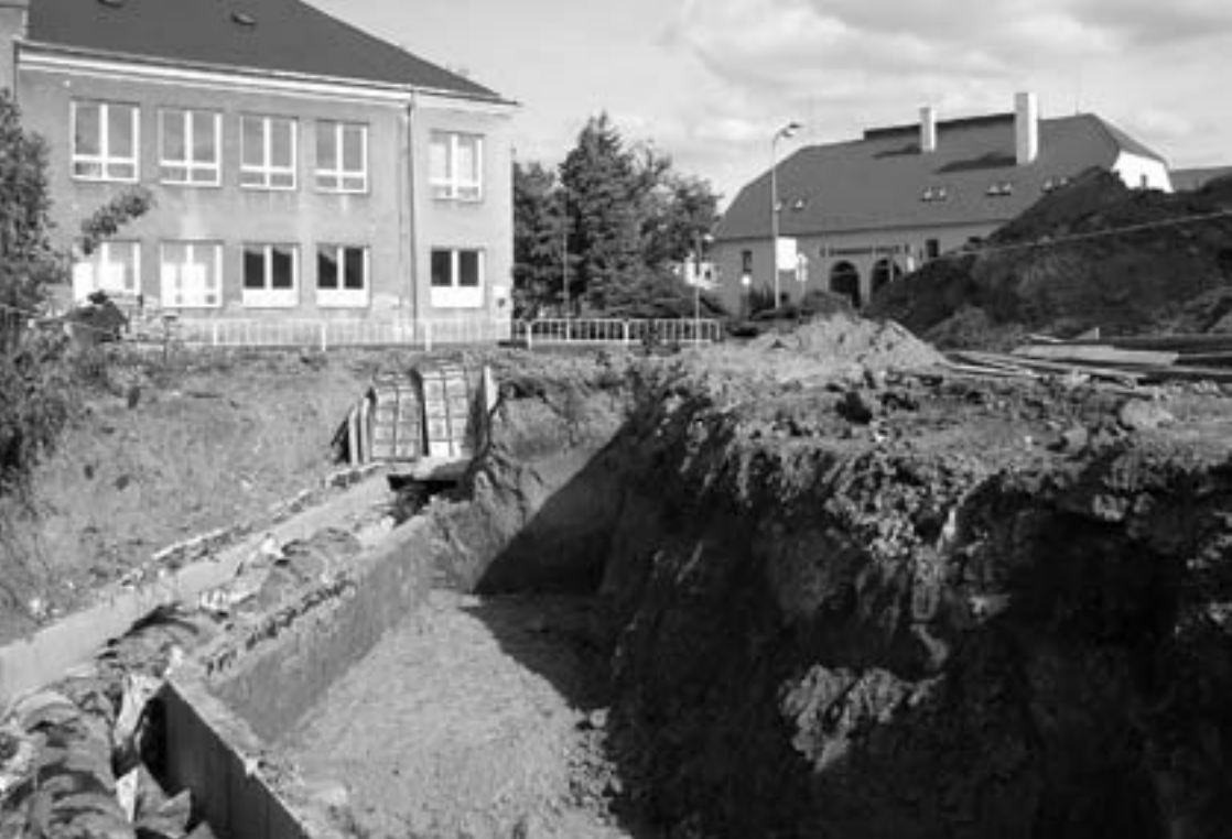
Obr. 2 Přerov. Malá Dlážka. Pohled od západu na trasu parovodního výkopu, kde došlo v roce 2005 k zachycení raně středověkých objektů (Foto. Z. Schenk)
