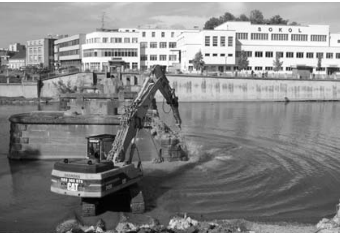
Obr. 19 Demolice původních mostních pilířů Tyršova mostu (foto. Z. Schenk)
