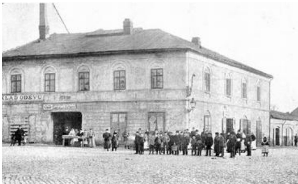
HOSTINEC U BÍLÉHO KONÍČKA. Se nacházel na rohu Dolního náměstí v místech dnešního Městského domu. Snímek je z konce 19. století, těsně před zbouráním budovy. Foto zaslal Jiří Lapáček
