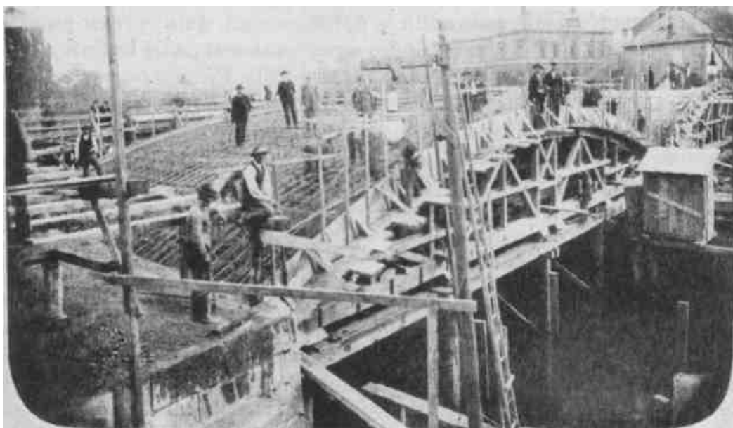
Skruž třetího oblouku a železná armatura pro betonové oblouky. Stav práce 20. 10. 1903. SOKA Přerov
