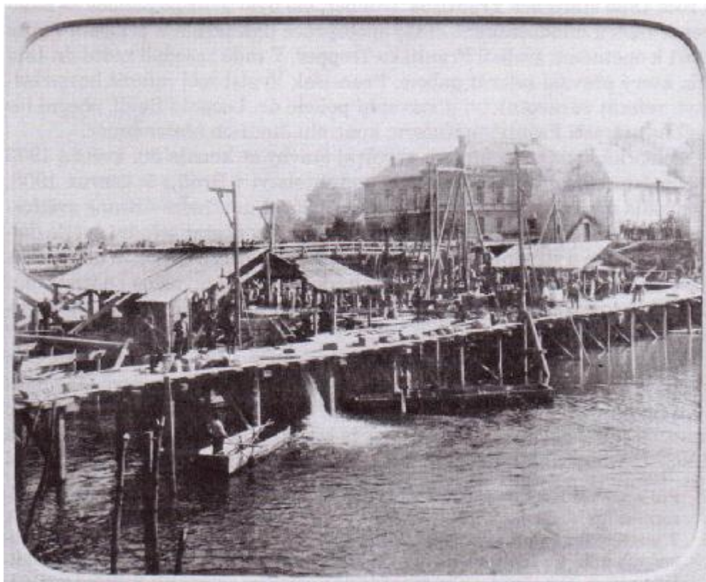
Zakládání čtyř pilířů na betonové piloty. Stav práce 20. 9. 1903. SOkA Přerov
