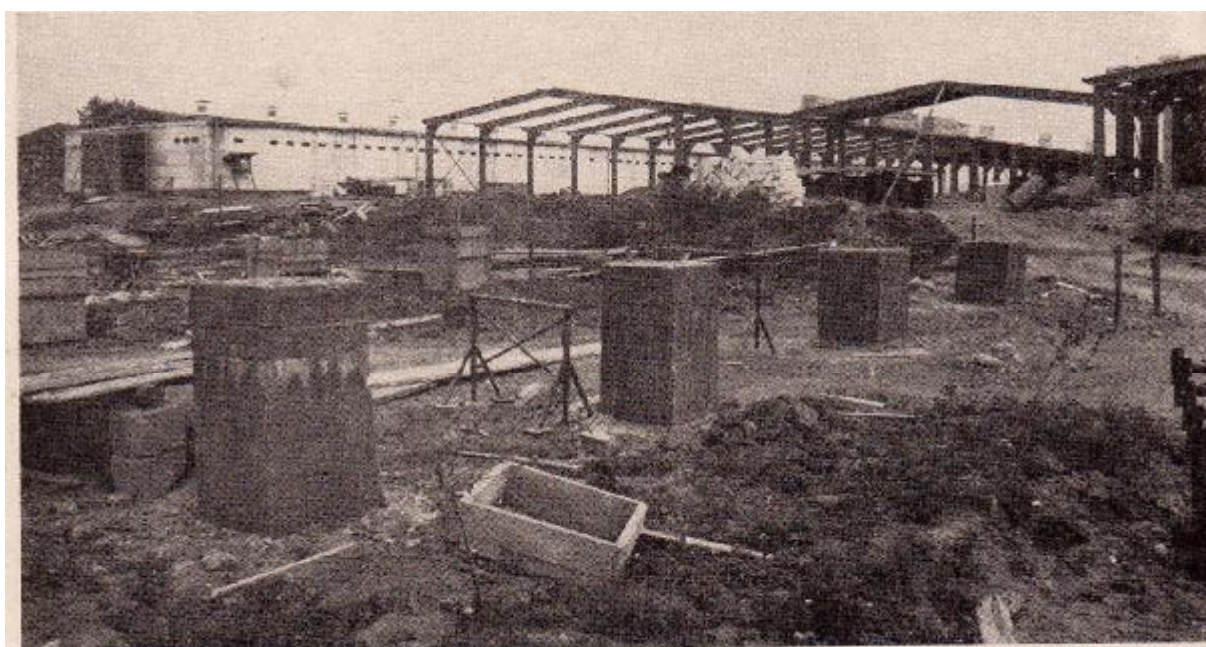
Výstavba drůbežářských závodů.
