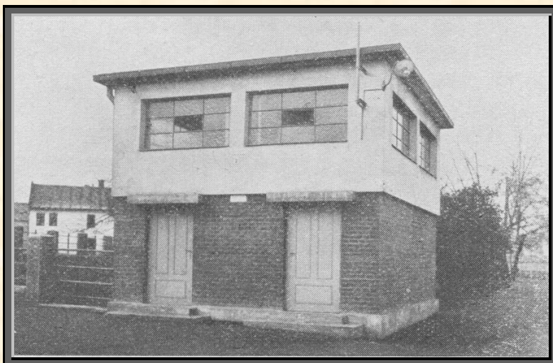
Městské transformační stanice
