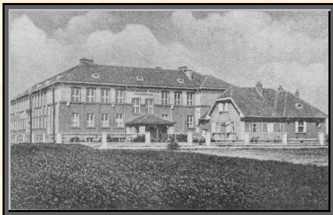
Nové budovy škol v Brodku
