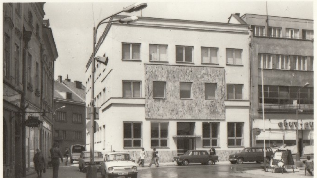
Rekonstrukce pojišťovny v Hranicích
