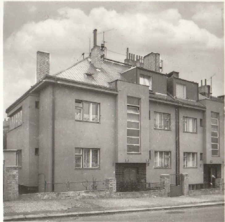
Adaptace a opravy bytů
